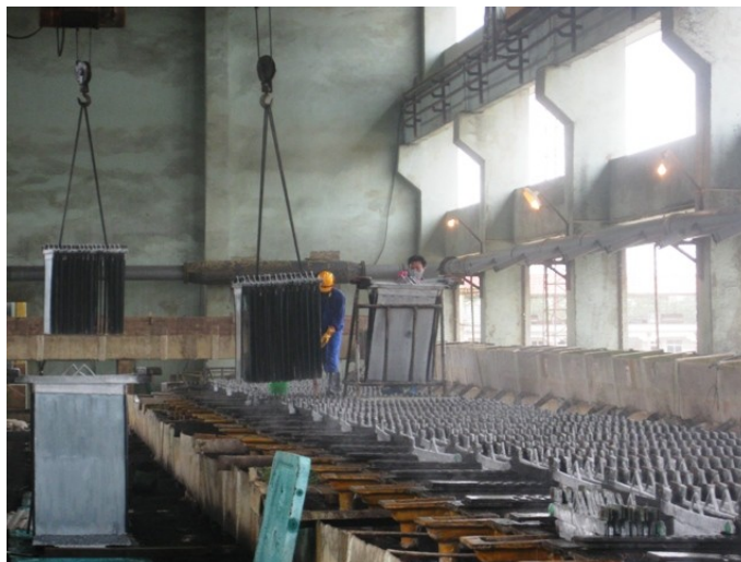
Bể điện phân bột kẽm ô xít
