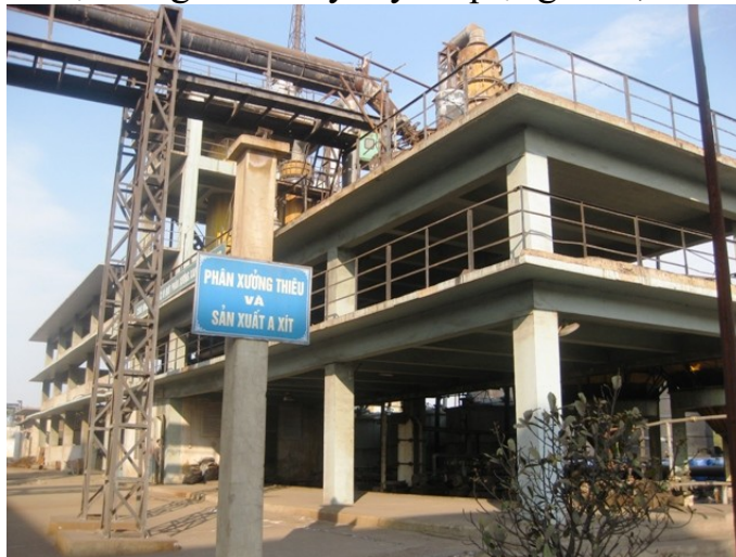
Thiêu tinh bột quặng kẽm sulfua cho ra bột kẽm ô xít và axit H_2SO_4
