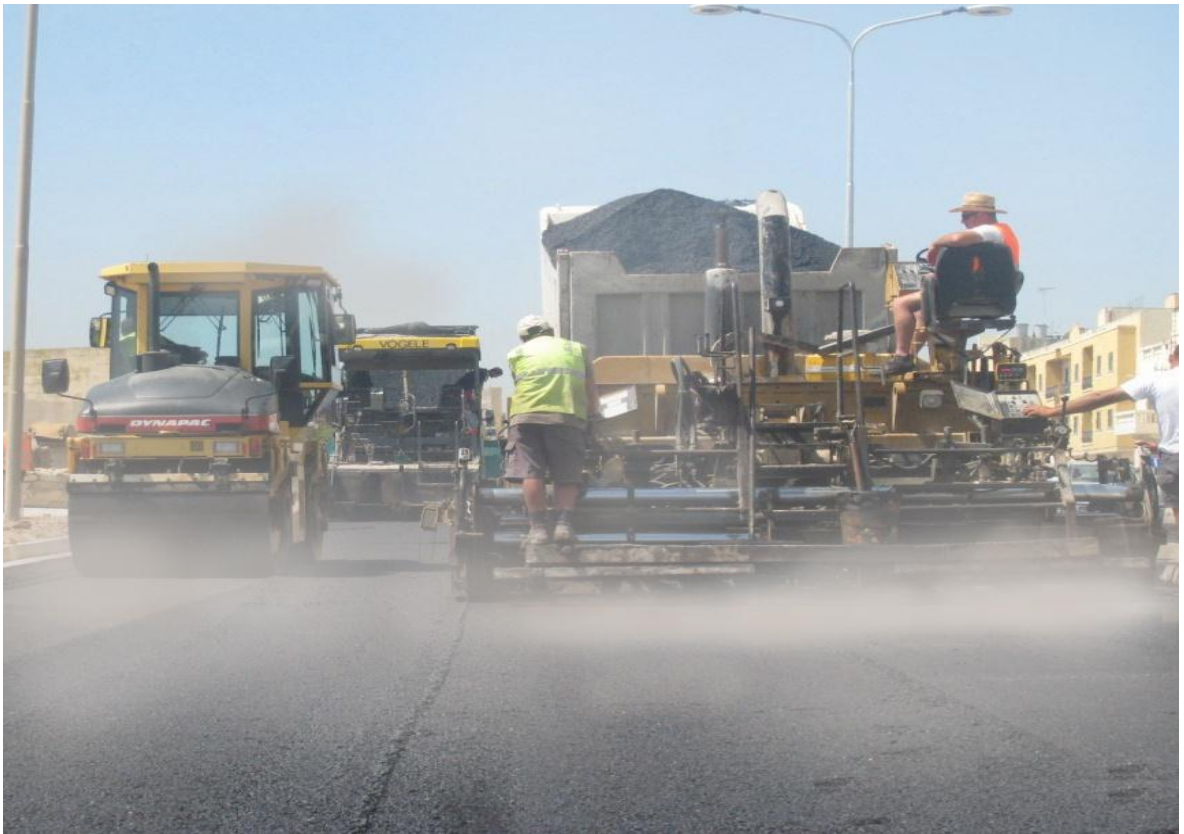
Hình 1.7. Máy thi công thảm nhựa đường mặt đường, mặt cầu phát thải nhiều hơi khí độc và bụi ra môi trường xung quanh
