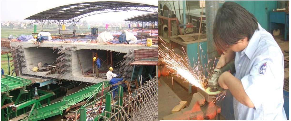
Hình 1.8-9. Công đoạn lắp đặt cốt thép khung và đúc bê tông mặt cầu gắn liền với công việc hàn, cắt, mài bavia
