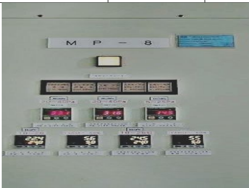
Hình 3.8: Bảng hiển thị của máy theo dõi nhiệt độ, độ ẩm, áp suất phòng thực hiện thử nghiệm vô trùng
