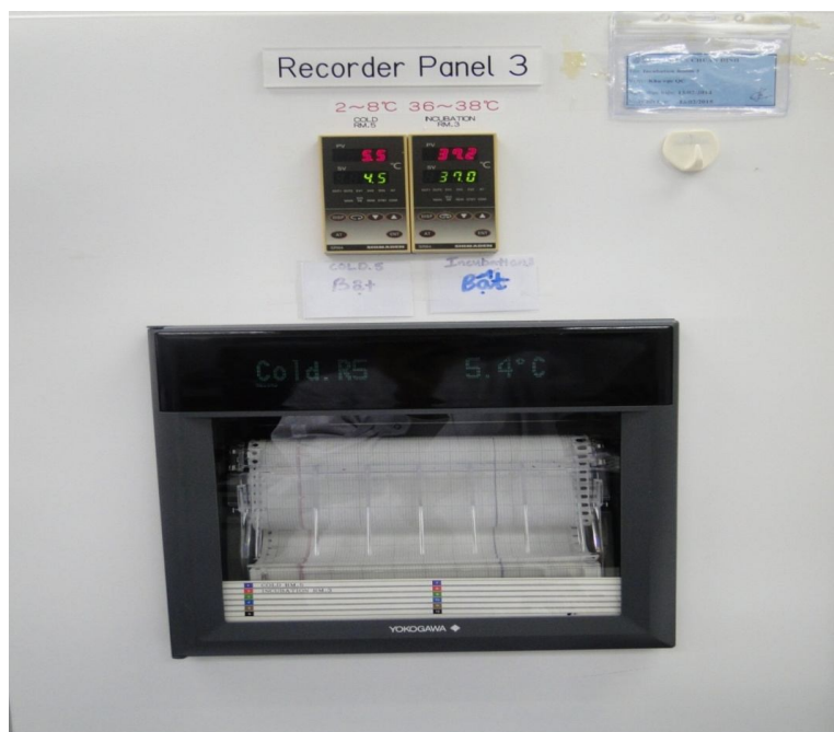
Hình 2.4: Bút ghi tự động và bảng hiển thị nhiệt độ các tủ bảo quản vắc xin.
